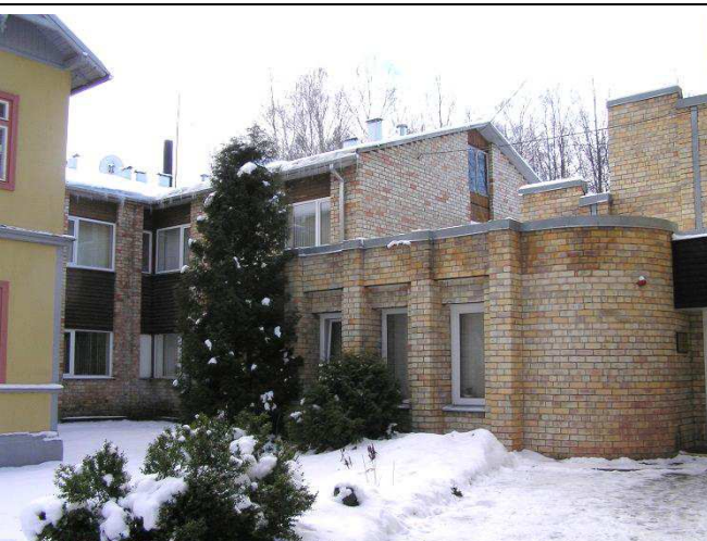
Zemesgabalā esošā ēka kad.nr.13000081609003
