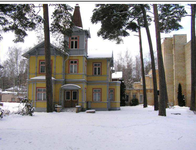
Zemesgabalā esošā ēka kad.nr.13000081609008
