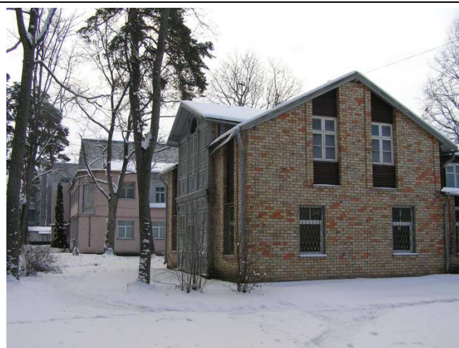
Zemesgabalā esošā ēka kad.nr.13000081609011
