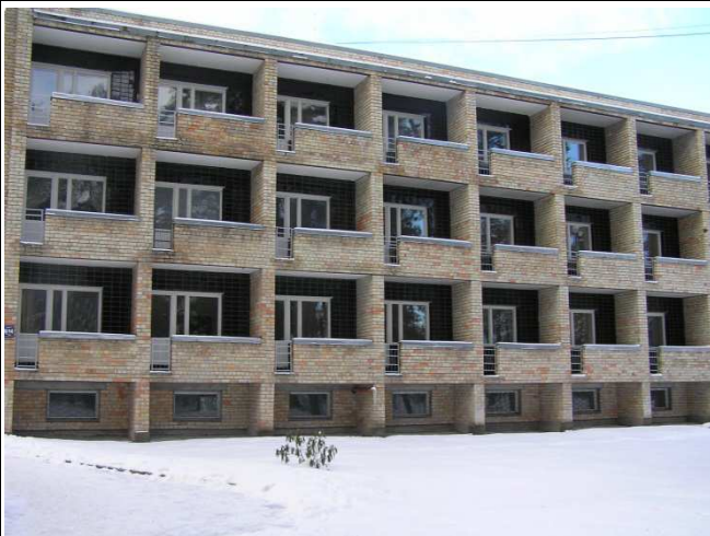
Zemesgabalā esošā viesnīcas ēka
